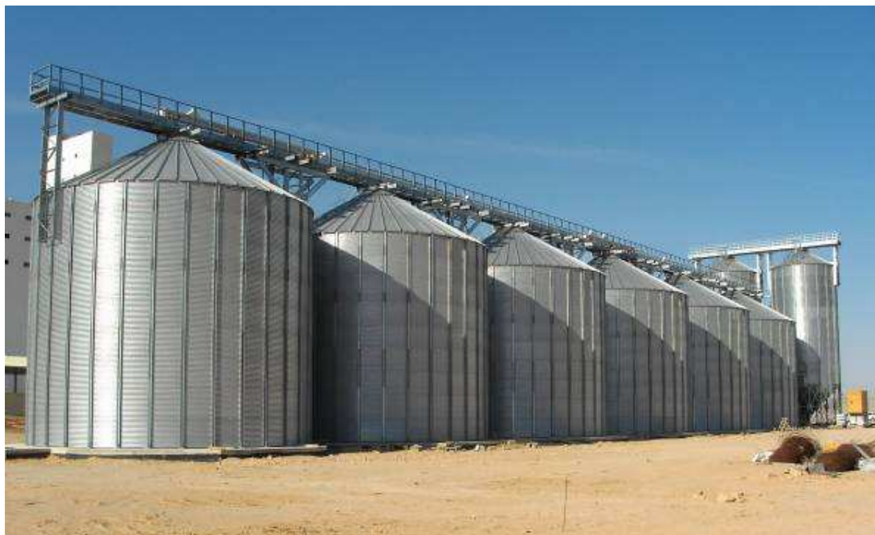
Libia – 6 Silozuri 1223/15 + 2 Silozuri 760/12T45
